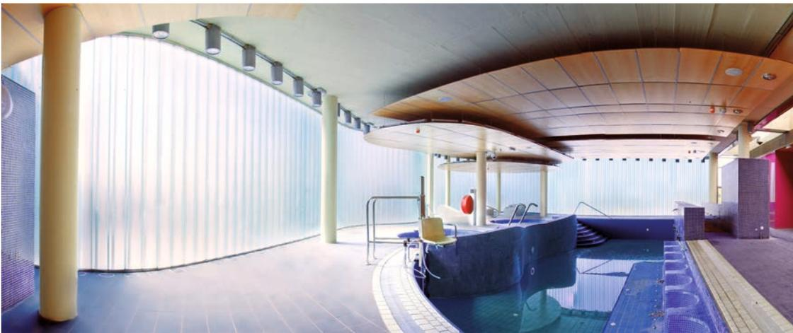
El sistema de perfiles de cristal autoportante U-Glas, es una novedosa alternativa a las actuales técnicas de cerramiento con vidrio.
