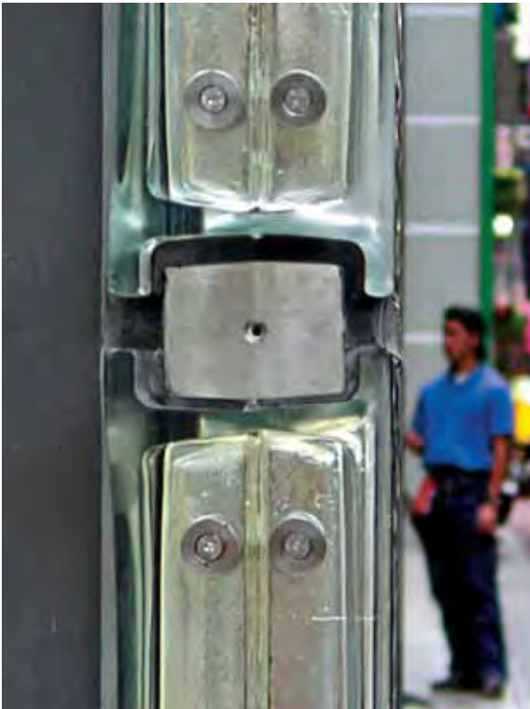
Detalle de la construcción de los paneles.Junta entre los paneles Detalhes da construção dos painéis. Juntas entre os painéis SEVES per Renzo Piano
